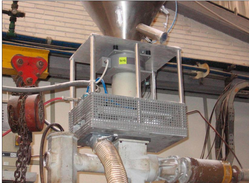
Der MFE Metall-Separator von Sesotec ist bei Vinipack direkt in den Materialeinzug des Extruders installiert.
