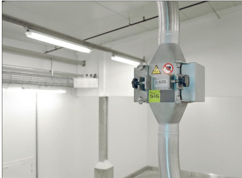
Der Plattenrohrmagnet von Sesotec separiert magnetische Metalle und ist in eine Rohrleitung mit Druckförderung eingebaut.
